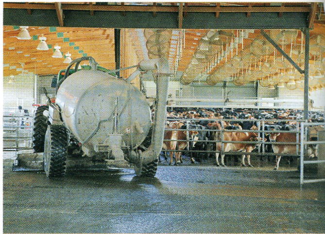
Mit dem Saugwagen können alle Stallbereiche gereinigt werden, auch Treibwege und Vorwartehöfe.
